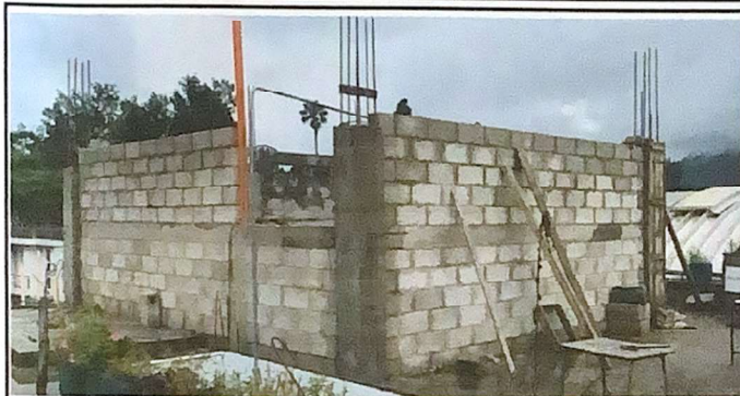
Foto 1: Reparación de cocina, apertura de espacios para ventanas y puertas
