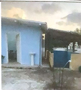
Foto 1: Reparación de cocina
