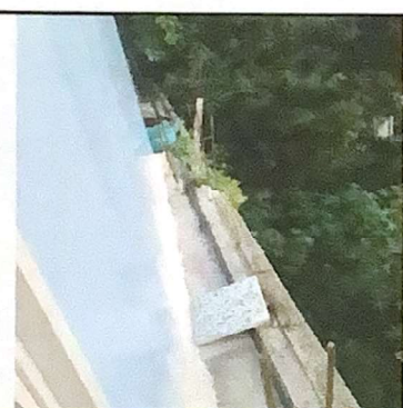
Foto 3: Ampliación y reparación de cocina
