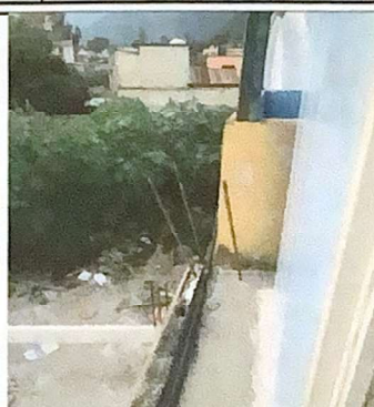
Foto 2: Ampliación de cocina
