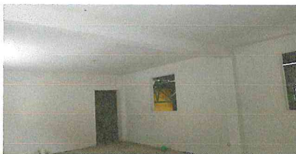
Foto 3: Muro de pared lado derecho repellada y terminada.
