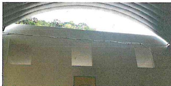
Foto 4: Pared parte interior de la escuela completamente terminada y con su respectivo repello.
