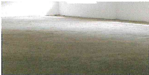
Foto 1: Losa de patio completamente mejorada y en un buen estado.
