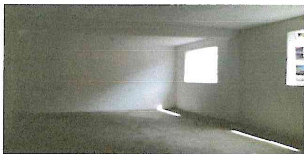
Foto 5: Losa de patio, de los salones terminados y completamente sin ninguna acumulación de agua.
