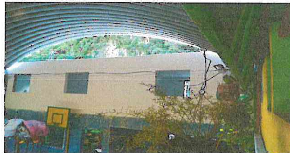
Foto 6: Perspectiva de como quedó terminado todo el Proyecto de Programa de Remozamiento de los Salones de Preprimaria y Primaria.
