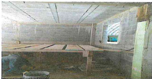
Foto 1: Losa de patio lo estan mejorando.
