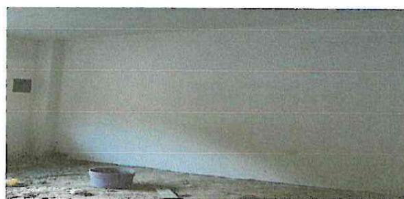
Foto 6: Muro de pared completamente mejorada.
