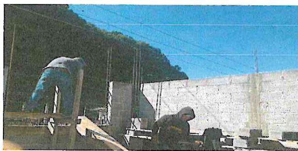
Foto 3: Muro de pared del lado derecho de la escuela.
