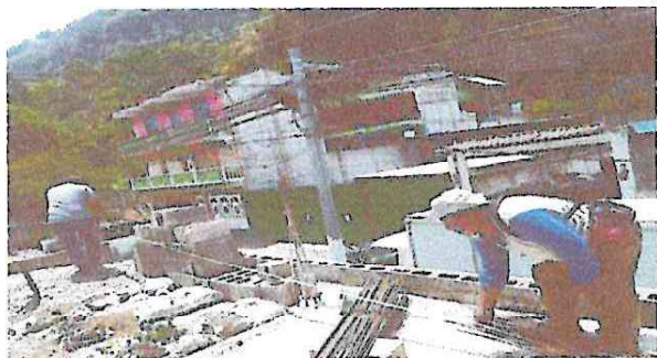
Foto 1: Losa de patio deteriorada y en mal estado.
