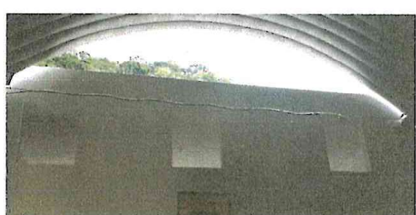
Foto 4: Pared parte interior de la escuela completamente terminada y con su respectivo repello.
