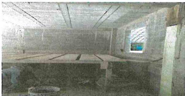
Foto 1: Losa de patio lo están mejorando.
