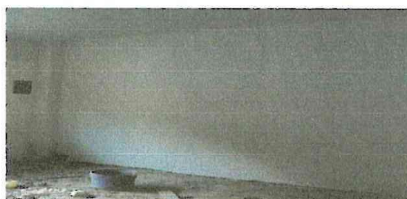
Foto 6: Muro de pared completamente mejorada.
