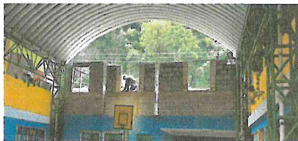
Foto 4: Pared de la parte interior de la escuela con muro de pared
