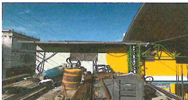
Foto 3: Otra perspectiva de losa y muro de pared de la escuela.
