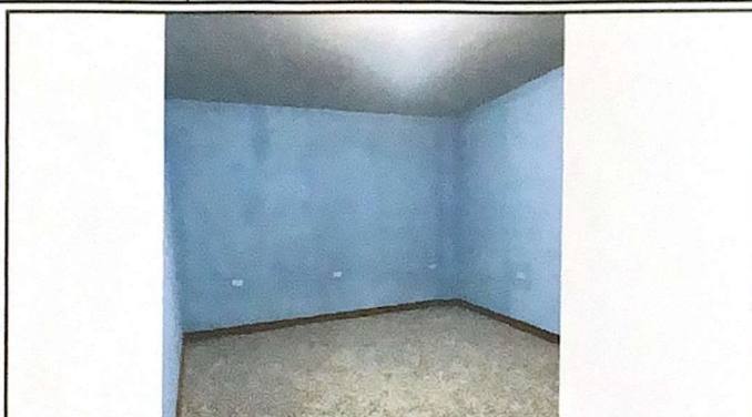
Foto 2: Ampliación de cocina parte de adentro
