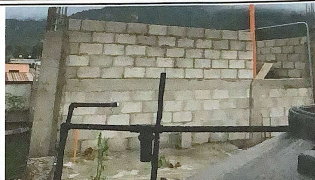
Foto 2: Ampliación de cocina
