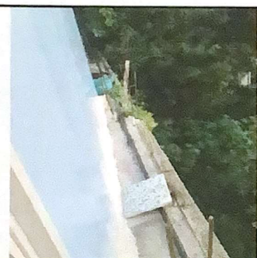
Foto 3: Ampliación y reparación de cocina
