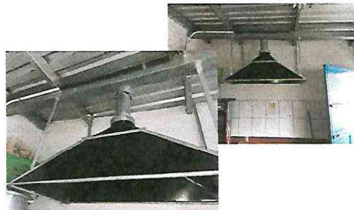
FOTO 7: CAMPANA DE HUMO INSTALADA
