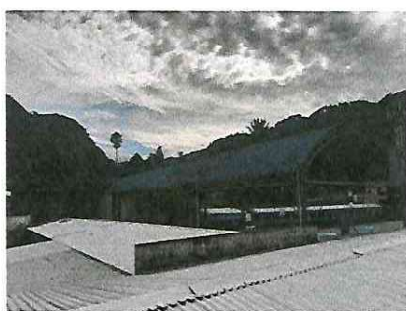
FOTO 5: TECHO DE LA CANCHA PINTADO
