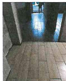
FOTO 9: PISO AULAS INSTALADO
