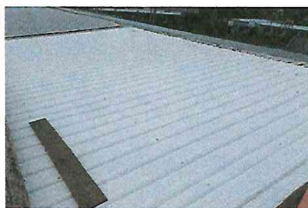
FOTO 6: TECHO DEL AULA TERMINADO
