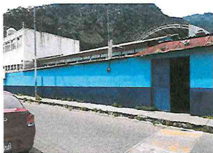
FOTO 1: PAREDES EXTERNAS PINTADAS
