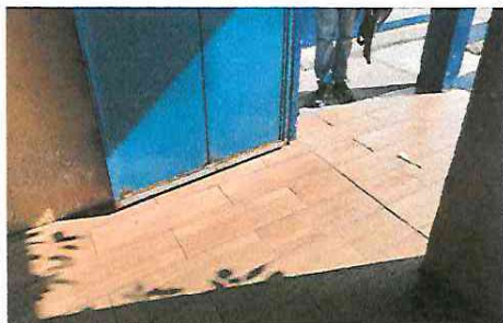
FOTO 9: PISO DIRECCIÓN INSTALADO Y CORREDOR BAÑOS
