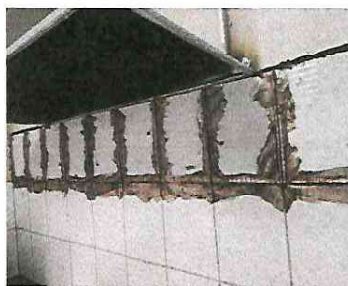
FOTO 9: INSTALANDO EL AZULEJO EN LA COCINA EN LA PARED QUE TENÍA MOHO.
