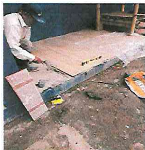
FOTO 7: INSTALANDO PISO CORREDOR BAÑOS
