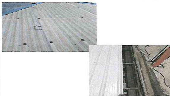
FOTO 2: ARREGLANDO TECHO AULA
