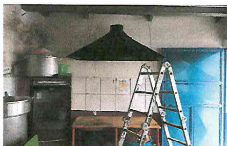
FOTO 11: INSTALACIÓN CAMPANA EXTRACTORA DE HUMO.
