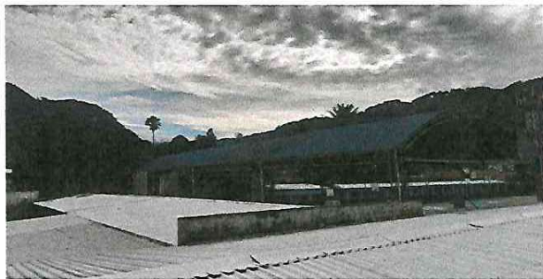
FOTO 1 : PINTANDO TECHO CANCHA DEPORTIVA
