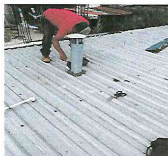
FOTO 10: INSTALANDO CAMPANA EXTRACTORA DE HUMO.
