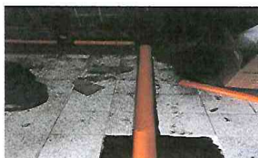
FOTOS : INSTALANDO MINGITORIOS
