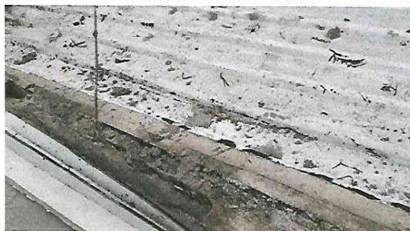
FOTO 4: ARREGLO TECHO AULA
