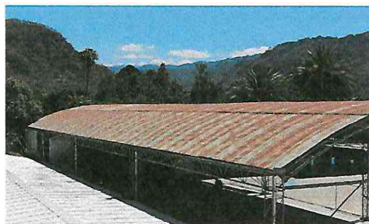
FOTO 2: ARREGLO TECHO CANCHA DEPORTIVA
