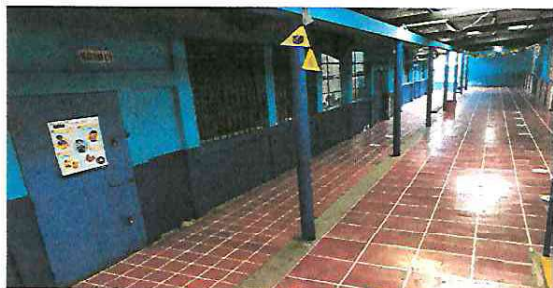
FOTO 5: PINTURA MUROS INTERIORES Y EXTERIORES
