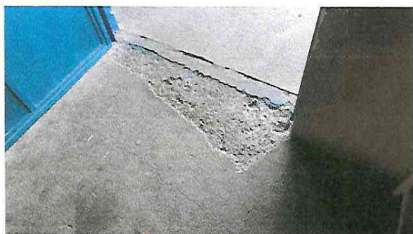
FOTO 9: REPARACIÓN DE PISO EN DIRECCIÓN
