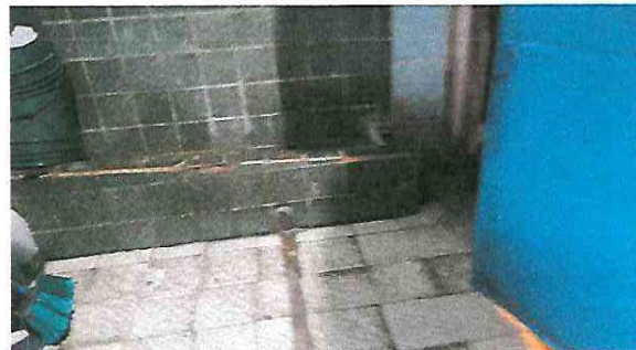
FOTO 8: ARREGLO DE MINGITORIOS
