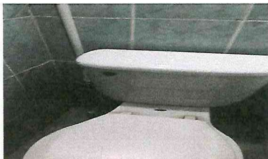
FOTO 7: ARREGLO DE SERVICIOS SANITARIOS
