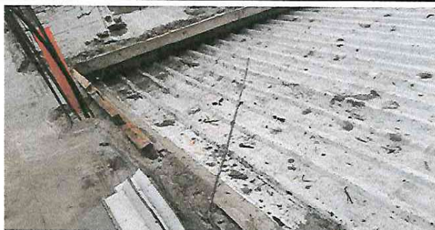
FOTO 3: ARREGLO TECHO AULA
