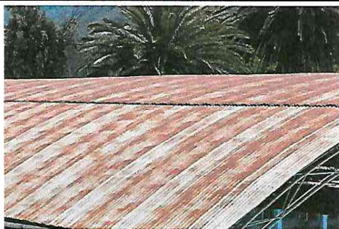
FOTO 1: ARREGLO TECHO CANCHA DEPORTIVA
