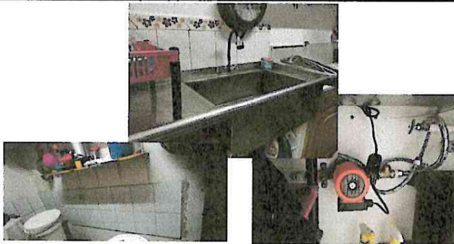
Foto 9: Sustitución de Lavatrastos y Accesorios de Cocina de la escuela
