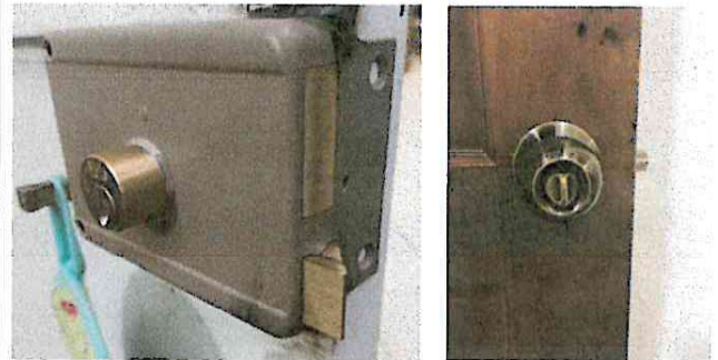
Foto 10: Sustitución de Chapas de puertas de aulas de la escuela.
