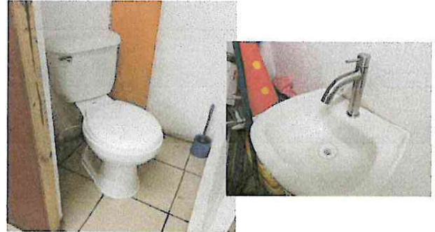
Foto 8: Colocación de Sanitario y Accesorios de Baño en aula de la escuela
