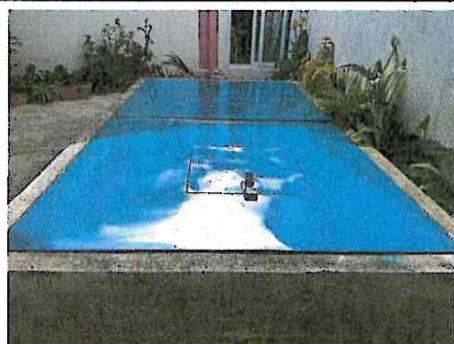
Foto 5: Colocación de Marco de Metal en Cisterna de Agua de la escuela.
