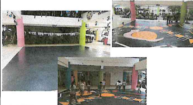
Foto 4: Sustitución de Loza de Patio y Pintado de la misma.
