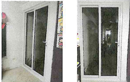
Foto 2: Colocación de Puerta Corrediza en aula de la Escuela
