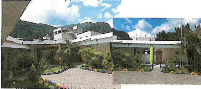
Foto 7: Impermeabilización de Loza de Terraza de la escuela.
