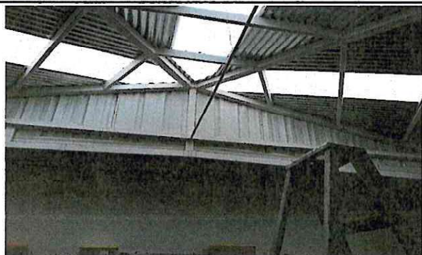
Foto 1: Sustrucción de Cubierta de Lámina
