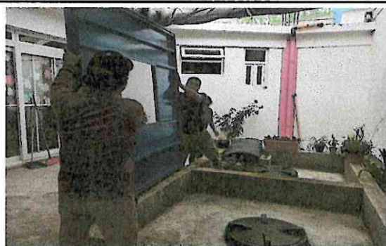
Foto 5: Proceso de Colocación de Marco de Metal sobre Cisterna de Agua, para resguardo de estudiantes.
