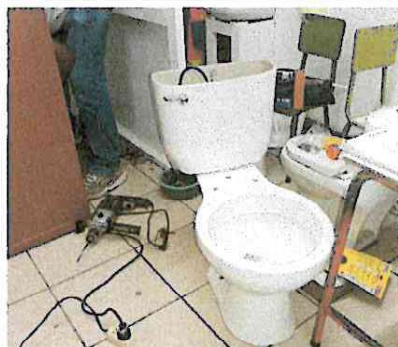
Foto 8: Proceso colocación de sanitario y accesorios del baño.
