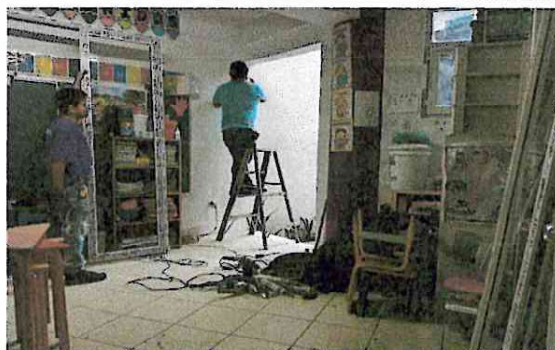
Foto 2: Colocación de Puerta Corrediza
