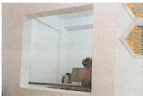
Foto 3: Colocación de Ventana de PVC
