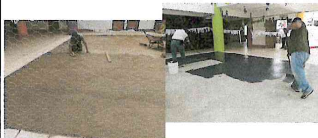
Foto 4: Proceso sustitución de Loza de Patio y pintado de la misma.
