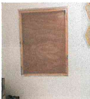
Foto 3: Colocación de ventana de PVC para mejorar la ventilación de aula
