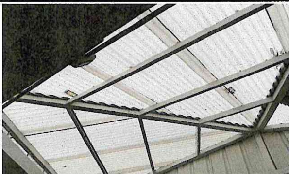
Foto 1: Sustitución de cubierta de lámina debido a filtración de agua
