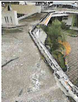
Foto 7: Impermealización de Loza para evitar filtración y deterioro de la misma.
