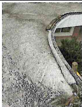
Foto 7: Impermealización de Loza para evitar filtración y deterioro de la misma.
