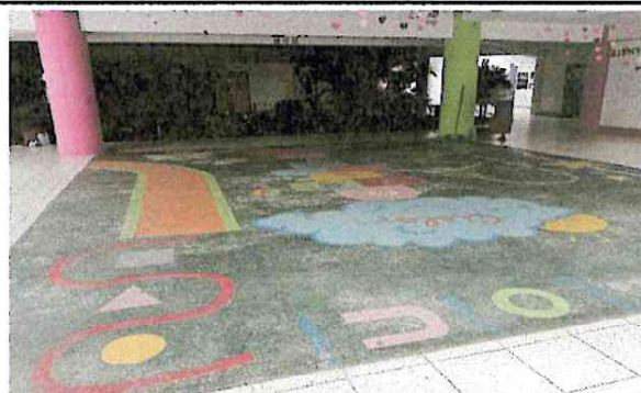
Foto 4: Sustitución de losa de patio, debido a quebrantamiento y deterioro de losa de corredor principal
