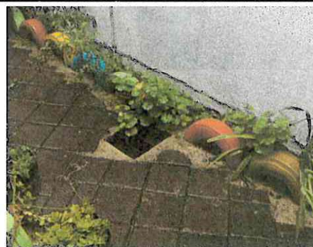
Foto 6: Colocación de rejilla de metal para protección del paso de los estudiantes
