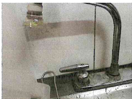
Foto 9: Sustitución de accesorios en cocina
