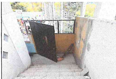
Foto 3: colocación de puertas en gradas del tercer nivel
