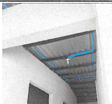
Foto 5: colocación de focos
