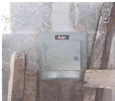
Foto 4: instalación de luz en caja electrica
