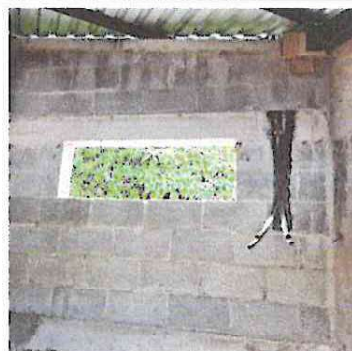
Foto 4: colocación de tablero electrico
