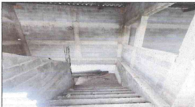
Foto 3: reparación de gradas del tercer nivel
