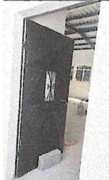
Foto 2: colocación de puertas
