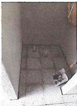
Foto 1: colocación de azulejos en sanitarios de niñas, niños y maestros
