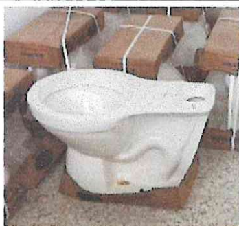
Foto 5: Instalación de sanitarios
