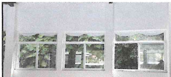
Foto 3: instalación de ventanas
