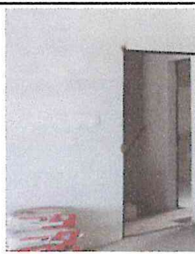
Foto 2: colocación de bases para puertas
