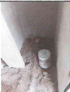
Foto 1: tubos de drenajes colocados en baños de niños, niñas y maestros
