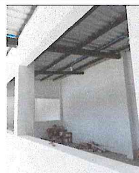
Foto 3: repello para colocación de ventanas
