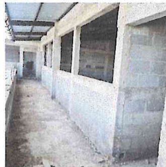
Foto 2: Colocación de puertas en aulas
