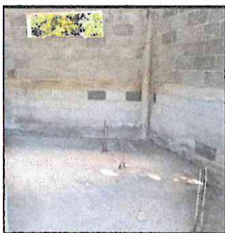
Foto 5: Colocación e instalación de sanitarios
