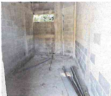
Foto 1: Colocación e instalación de drenaje en los baños de niños, niñas y maestros.
