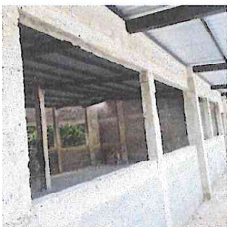
Foto 3: Colocación e instalación de ventanas en aulas
