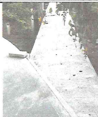
Ajustes en la nivelación de la losa de patio
