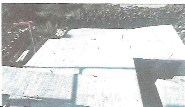
Losa de Patio finalizada
