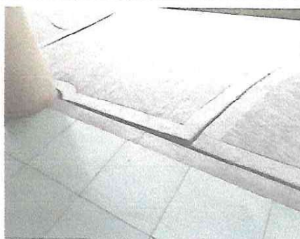
Levantamiento del piso de la rampa
