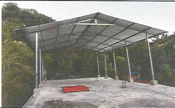
Estructura de Techo
