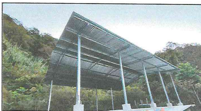
Conclusión del remozamiento
