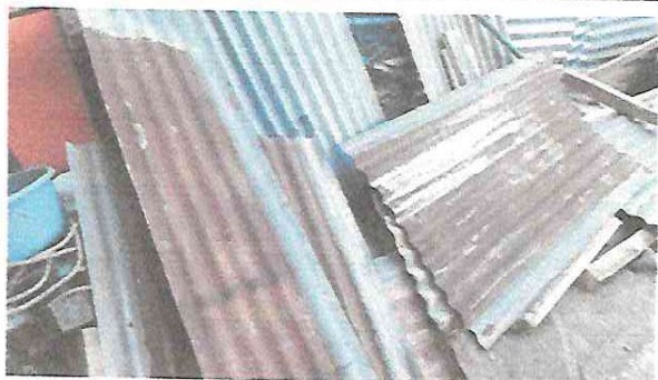
Desmantelación de galera
