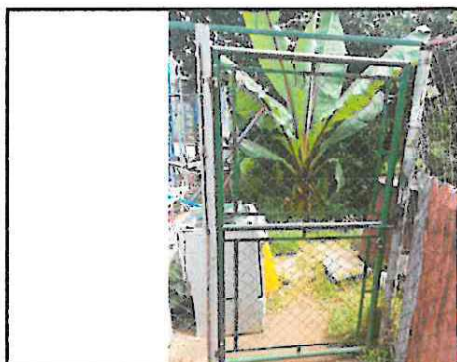
Foto 7: SUSTITUCIÓN DE PUERTA
