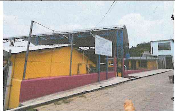
Foto 2: MURO PERIMETRAL PARTE DE FRENTE DE LA ESCUELA
