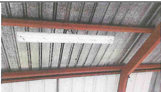
Foto 9: SUSTITUCIÓN DE LÁMPARAS LED
