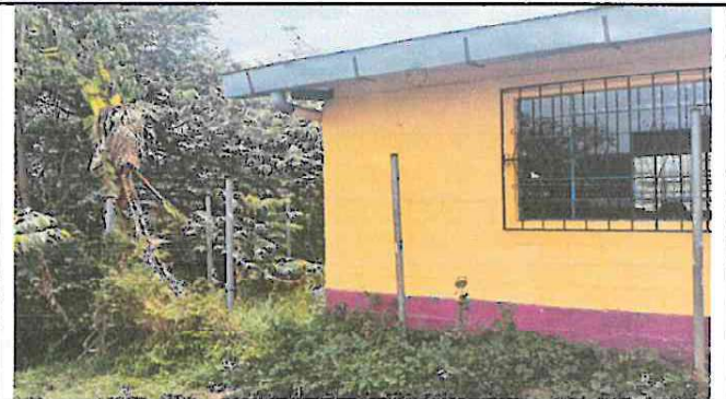
Foto 4: MURO PERIMETRAL PARTE TRASERA DE LA ESCUELA
