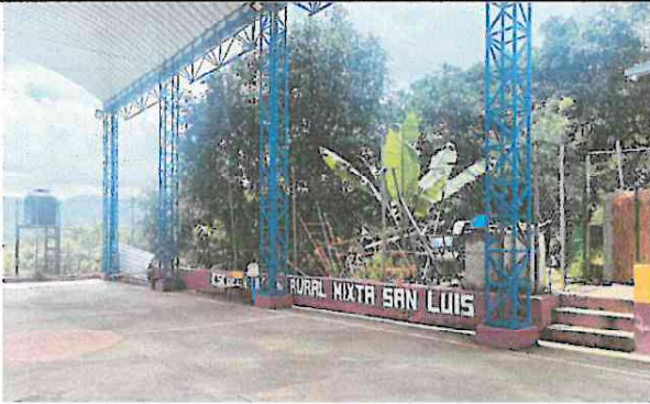
Foto 1: MURO PERIMETRAL PARTE NORTE DE LA ESCUELA
