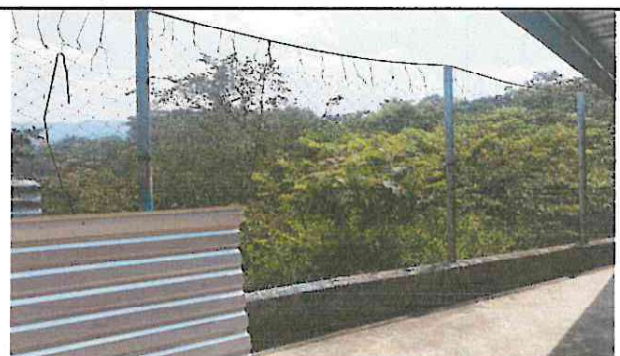
Foto 6: COLOCACIÓN DE PUERTA Y CONTINUACIÓN DE MURO PERIMETRAL PARTE ESTE.
