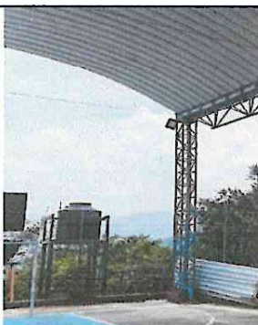
Foto 5: CONTINUACIÓN DE MURO AL FONDO DE LA CANCHA
