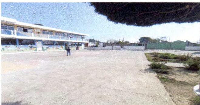
Foto 9: VISTA FRONTAL DE PATIO DONDE SE AGREGARÁ ESTRUCTURA METALICA CON COLUMNAS Y LAMINA TROQUELADA
