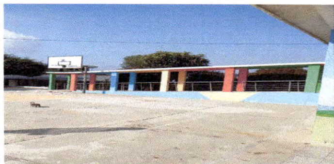
Foto 12: VISTA A PATIO DESDE MÓDULO DE AULAS
