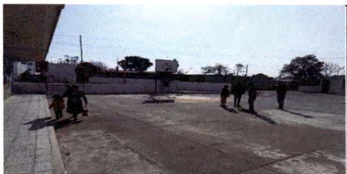
Foto 10: VISTA TRASERA DE PATIO DONDE SE COLOCARA ESTRUCTURA DE METAL
