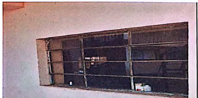
Foto 10: Ventana donde se colocarán balcones.
