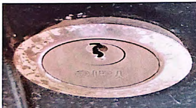
Foto 3: Sustitución de siete chapas que presentan algún desperfecto.
