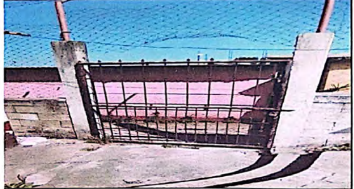
Foto 8: A este portón lateral se le instalará el techado, para su mayor conservación, como se puede observar en la actualidad no tiene techado.
