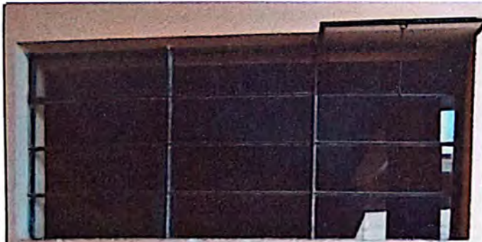
Foto 9: Sustitución de 4 ventanas por ventanas de aluminio.
