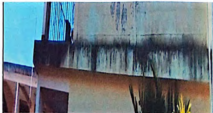
Foto 12: Áreas de la terraza, donde se aplicará pintura impermeabilizante.
