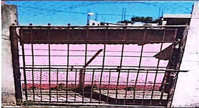
Foto 7: Portón lateral pequeño de rejillas, será sustituido por uno de lámina.
