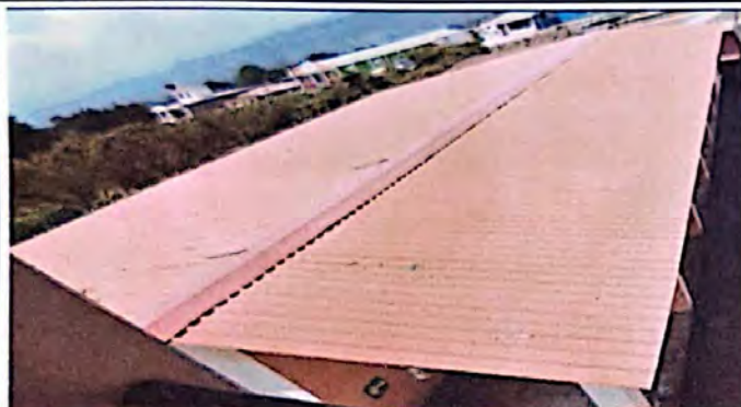
Foto 1: Tejado de lámina, se le aplicará pintura anticorrosiva para prolongar su conservación.
