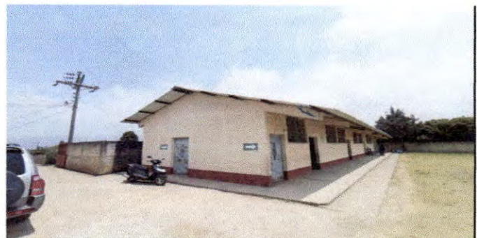
Foto 10: VISTA LATERAL DONDE SE IMPLEMENTARÁ DRENAJE Y PISO TORTA DE CONCRETO
