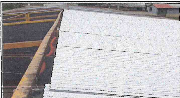
Foto 1. Láminas que cambiar por el mal estado en que se encuentran, algunas están rotas y en tiempo de lluvia gotea, por lo que es importante reemplazarlos por unos nuevos.
