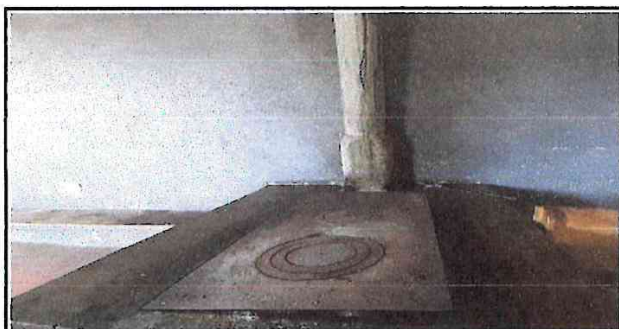
Foto 5. Las planchas ya no se pueden enderezar, igualmente los tubos están rajados, por lo que es importante reemplazarlos por unas nuevas, porque aquí es donde se prepara alimento para los niños.
