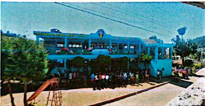
Foto 9: APLICACIÓN DE PINTURA GENERAL
