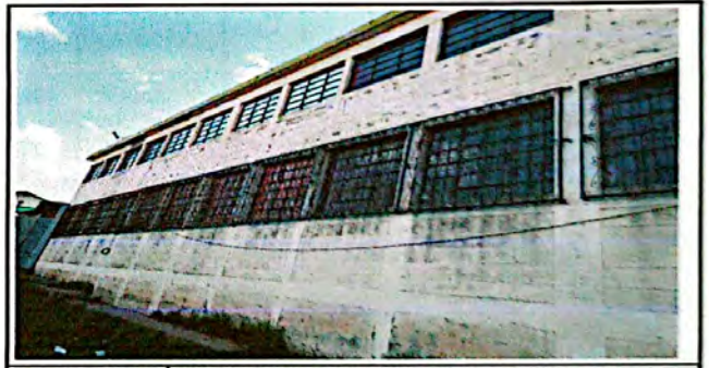
Foto 10: INSTALACIÓN DE BALCONES DE METAL EN ESTABLECIMIENTO
