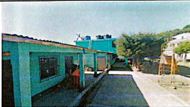
Foto 2: INSTALACIÓN DE BALCONES DE METAL EN MÓDULO DE AULAS
