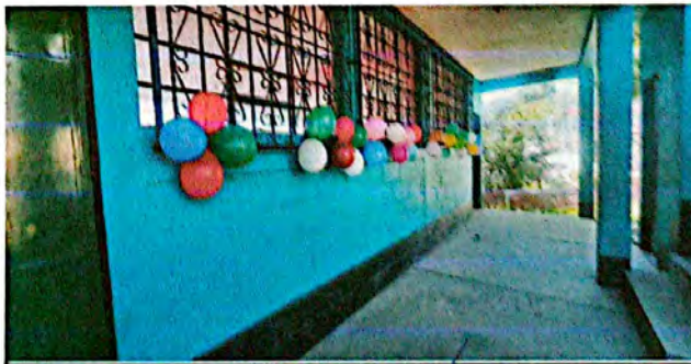
Foto 6: INSTALACIÓN DE BALCONES DE METAL
