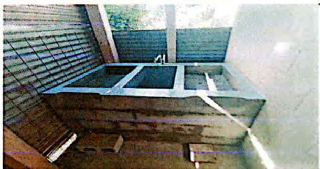
Foto 4: INSTALACIÓN DE TUBERIA PARA DRENAJE Y PILA DE CONCRETO
