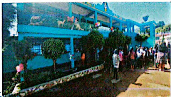
Foto 5: APLICACIÓN DE PINTURA EN MURO
