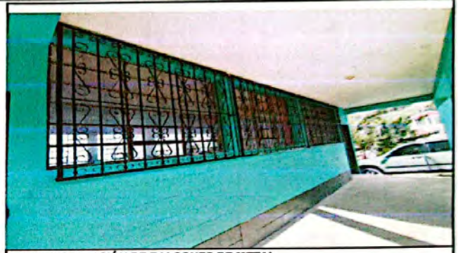
Foto 8: INSTALACIÓN DE BALCONES DE METAL
