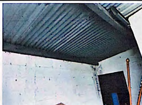
Foto 6: Cocina no cuenta con la energia Electrica
