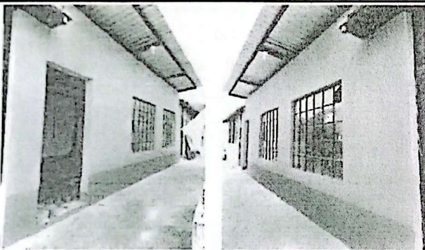
FOTO 3: Modulo de aula finalizado
