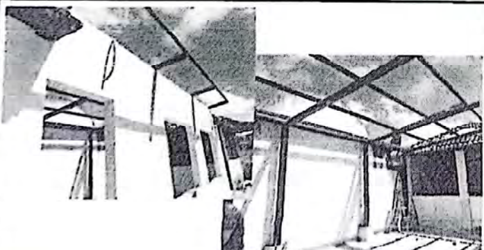
FOTO 5: Colocación de cubierta de estructura metálica en aula de Informática.
