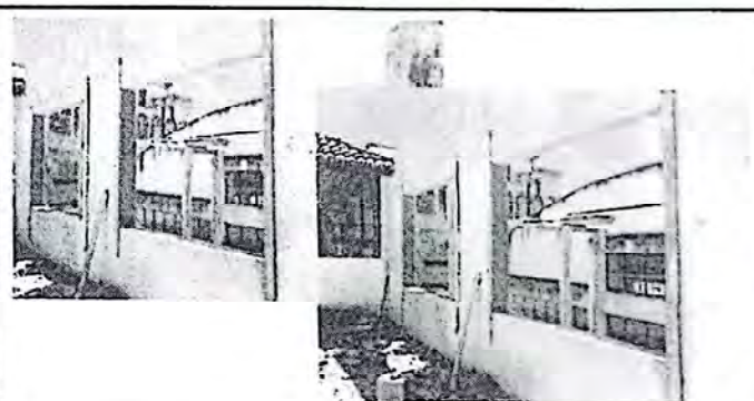
FOTO 4: Aplicación de acabados en muro perimetral reforzado.
