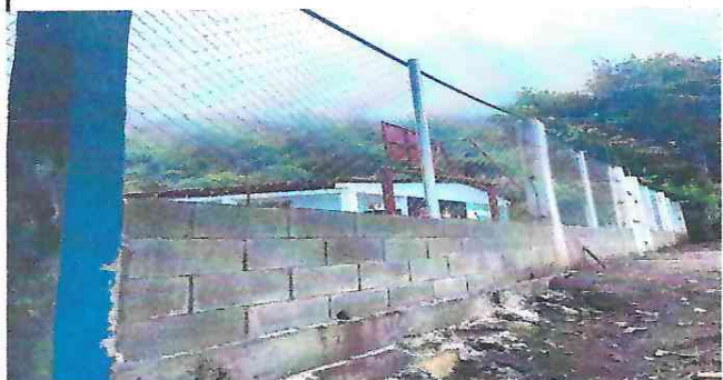
Terminación de muro perimetral
