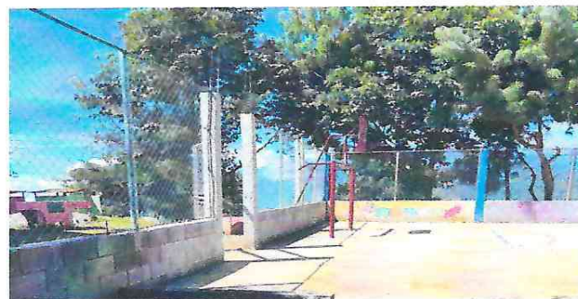
Terminación de muro perimetral
