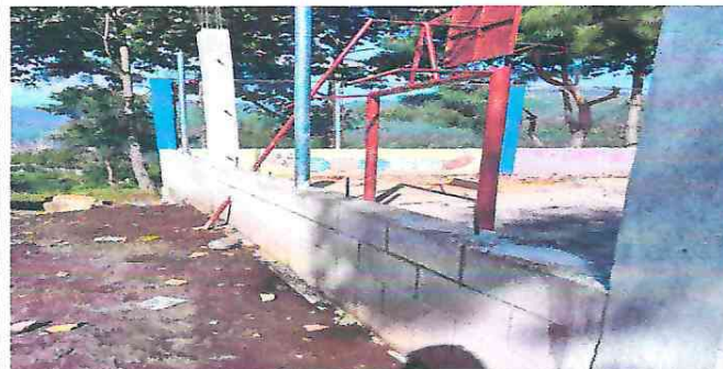
construccion de muro perimetral de la escuela
