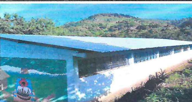
cambio de techado de la escuela
