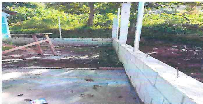
Construcción de muro perimetral de la escuela
