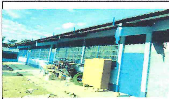
Foto 2: Colocación de canales con bajada pluvial y mantenimiento de puertas.
