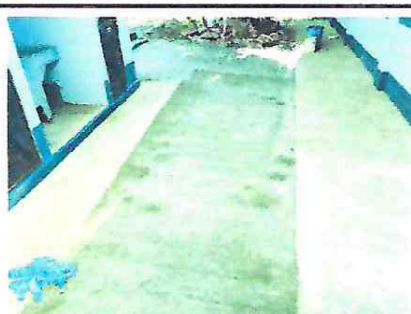
Foto 6: Sustitución de Pila y losa.
