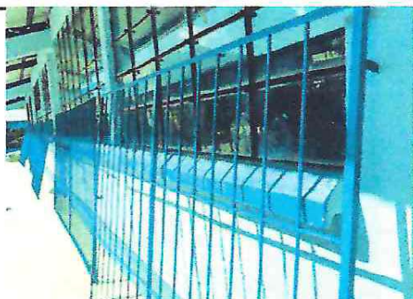
Foto 3: Colocación de balcones en modulo 1 y 2.
