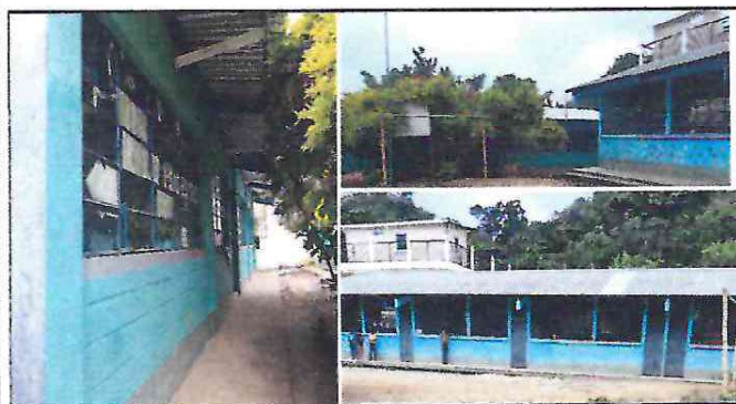
Foto 3: Colocación de 11 balcones o barandas en frente de los módulos 1 y 2.
