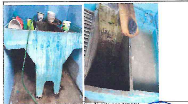
FOTO 6: Sustitución y fabricación de pila con tanque.
