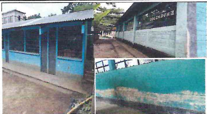
Foto 1: Pintura general del modulo 1 y 2, compuestos por 1 dirección y 5 aulas, exterior e interior.
