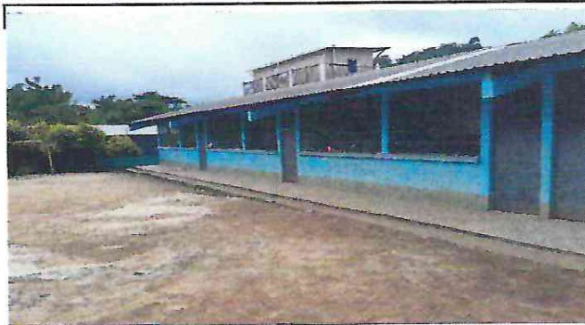
Foto 2: Colocación de canales de metal con bajada pluvial para modulos 1 y 2. Así mismo, Mantenimiento a estructuras de metal de 9 puertas.
