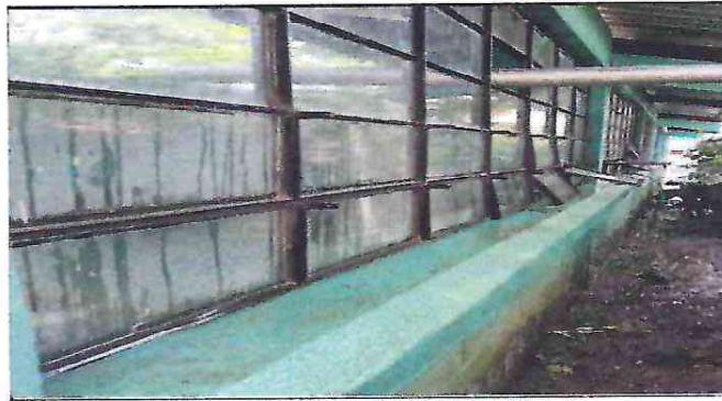
Foto 4: Repello y alisado de la parte de atrás del módulo 1.
