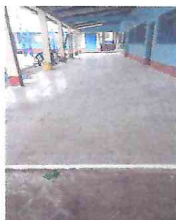
Foto 3: Colocación de pisos cerámicas, terminado en las tres aulas y corredor.
