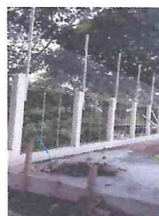
Foto 2: Colocación de maya terminado.
