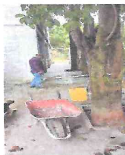
Foto2: Proceso de piso, torta de cemento atrás de la escuela.
