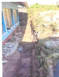
Foto4: Proceso de reparación de muro.
