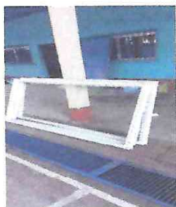
Foto5: Sustitución de ventanas en las tres aulas.
