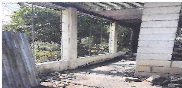
Instalación de una puerta de la cocina para mayor seguridad.
