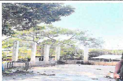
Se necesita aumentar 1.50 metros de la altura de la circulación, con tubos galvanizados y de tela malla, para garantizar el área de juegos de los niños de párvulos y de preprimaria.
