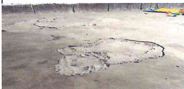
Sustitución de pisos de torta por piso cerámico en 3 aulas.
