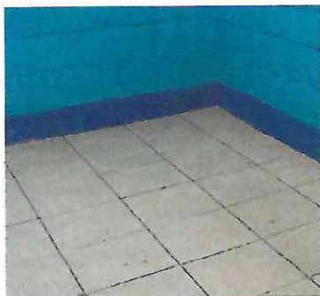
Foto 7: Sustrucción de piso de concreto a piso de cerámica, en la Dirección del centro educativo.
