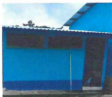
Foto 9: Cambio de techado y aplicación de pintura en modulo de sanitarios.
