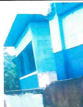
Foto 10: Ampliación de muro perimetral en la parte de atrás del centro educativo.
