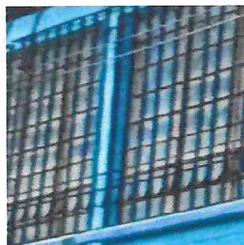
Foto 8: Instalación de balcones a ventanas del centro educativo, módulo 1.
