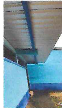
Foto 2: Aplicación de pintura en costaneras de baño
