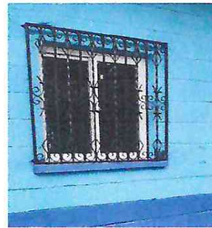
Foto 4: Instalación de ventana pvc corrediza.
