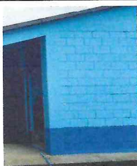
Foto 11: Aplicación de pintura en pared, en la parte exterior del edificio escolar.
