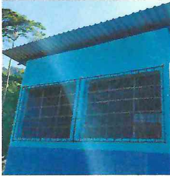
Foto 1: Colocación de balcón en cocina escolar.
