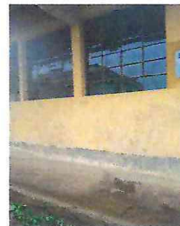
Foto 6: Cambio de 60 piezas de vidrio en ventanas. Módulo 2
