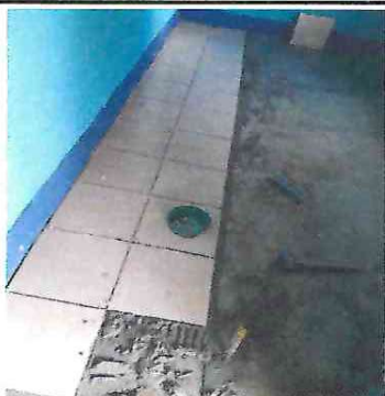
Foto 7: Sustrucción de piso de concreto a piso de cerámica, en la Dirección del centro educativo.
