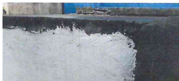
Foto 10: Ampliación de muro perimetral en la parte de atrás del centro educativo.
