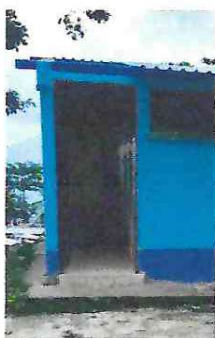
Foto 9: Cambio de techado y aplicación de pintura en modulo de sanitarios.
