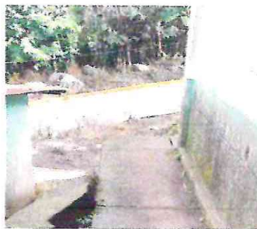
Foto 10: Ampliación de muro perimetral en la parte de atrás del centro educativo.
