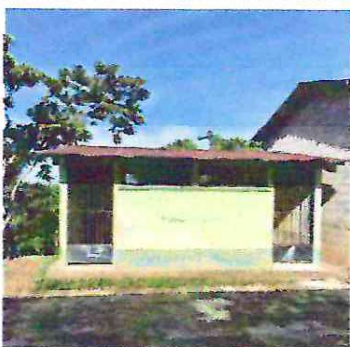
Foto 9: Cambio de techado y aplicación de pintura en modulo de sanitarios.
