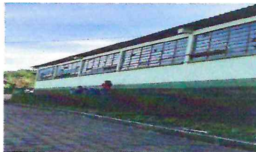
Foto 8: Instalación de balcones a ventanas del centro educativo, módulo 1.
