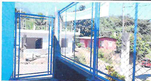
Foto 1: Fotografía del área donde se finalizó el renglón de muro perimetral, reparación de malla
