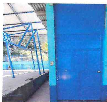
Foto 2: Fotografía del área donde se finalizó el renglón de puertas, repación y sustitución de puertas
