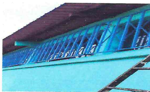
Foto 6: Fotografía del área donde se finalizó el renglón de ventanas, reparación de balcones y sustitución de vidrios.
