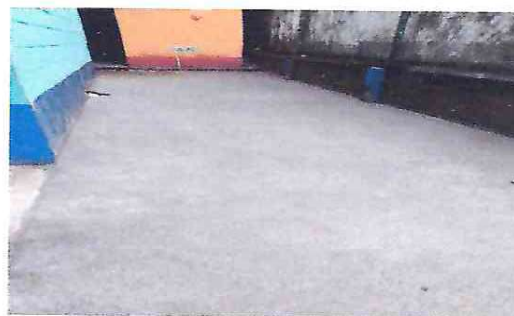
Foto 4: Fotografía del área donde se finalizó el renglón, losa de patio.
