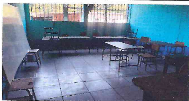
Foto 3: Fotografía del área donde se finalizó el renglón de piso.
