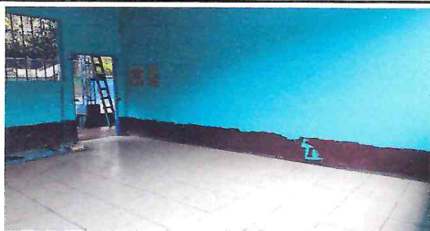
Foto 3: Fotografía del área donde se intervino el área de piso y pintura
