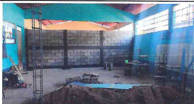
Foto 5: Fotografía del área donde se intervino el renglón de muros perimetrales
