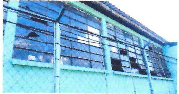
Foto 4: Sustitución de vidrios de aulas
