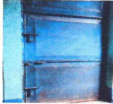
Foto 2: Mantenimiento puertas de cocina y aulas
