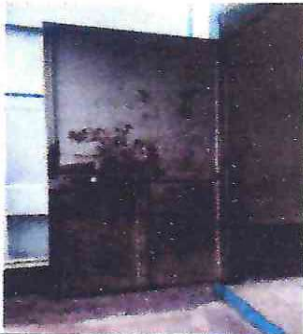
Foto 1: Sustitución de puertas de aulas
