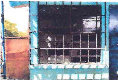
Foto 3: Sustitución de Vidrios cocina
