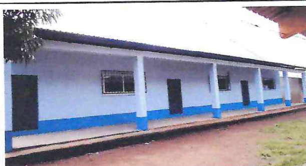
FOTO 3: Reparación y mantenimiento de puertas de metal (lijado, cepillado de dos mano con pintura anticorrosiva del modulo 1.
