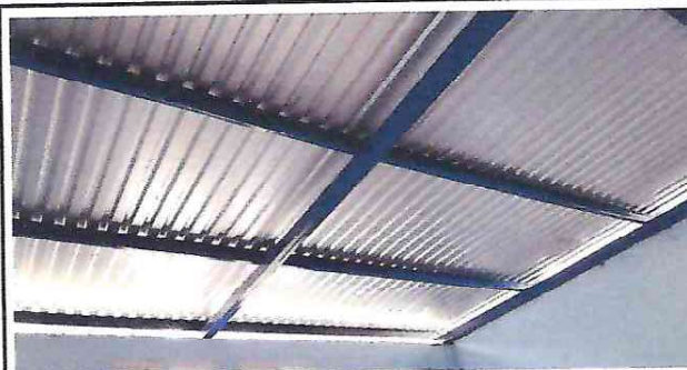
FOTO 2: Cambio de soporte de madera por Costaneras 4x2 legitimo del modulo 1
