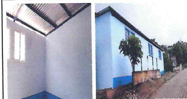
FOTO 4: Pintura en muros exteriores e interiores modulo 1
