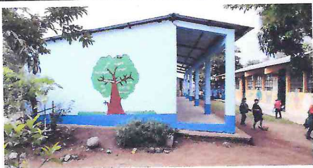
FOTO 1: Cambio de lamina y capotes por lamina y capotes troquelada calibre 26 del modulo 1
