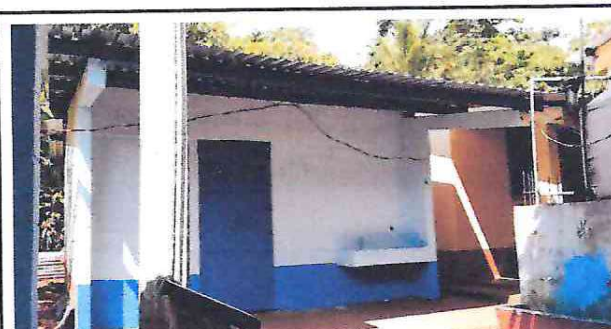
FOTO 5: Sustitución de lamina por lamina troquelada calibre 26 del baño sanitario y mantenimiento de soporte costanera
