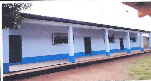
FOTO 8: Fabricación e instalación de ventanas de U pvc del modulo 1
