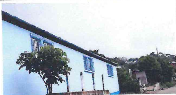
FOTO 7: Fabricación e instalación de ventanas de U pvc en modulo 1
