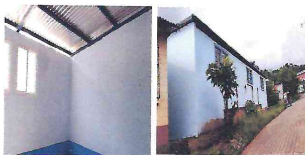
FOTO 4: Pintura en muros exteriores e interiores modulo 1
