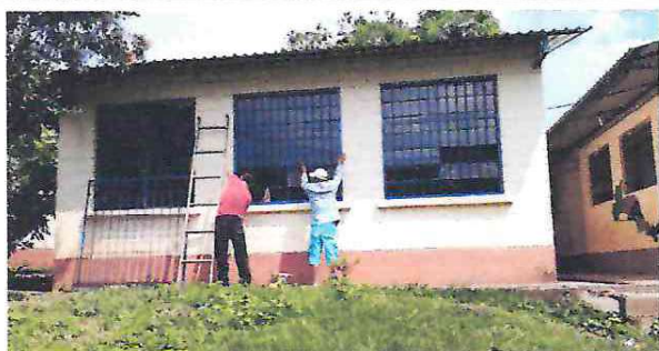
FOTO 9: Fabricación e Instalación de balcones para ventanas del modulo 3
