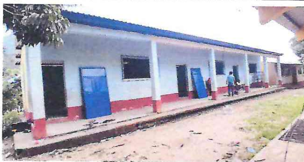
FOTO 3: Reparación y mantenimiento de puertas de metal (lijado, cepillado de dos mano con pintura anticorrosiva del modulo 1.
