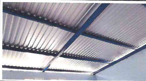
FOTO 2: Cambio de soporte de madera por Costaneras 4x2 legítimo del modulo 1
