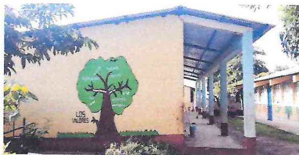
FOTO 1: Cambio de lamina y capotes por lamina y capotes troquelada calibre 26 del modulo 1
