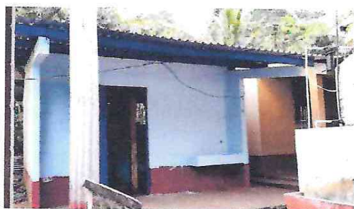
FOTO 5: Sustitución de lamina por lamina troquelada calibre 26 del baño sanitario y mantenimiento de soporte costanera
