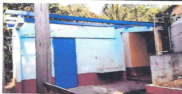
FOTO 6: Mantenimiento de puerta de baño sanitario, lijado, cepillado a dos mano con pintura anticorrosiva.
