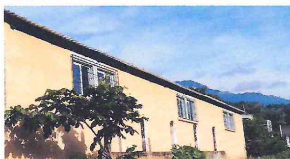
FOTO 10: Fabricación e Instalación de balcones para ventanas del modulo 1
